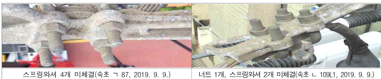
[그림 6] 클램프 체결상태 재점검 결과(2019. 9. 9.)
