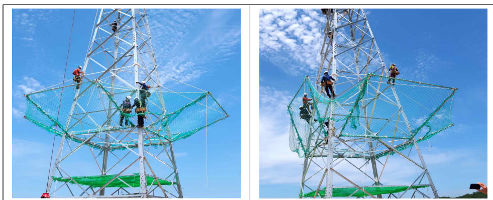
[사진 3] 송전첼탑 외부 추락방지망 설치 사진
