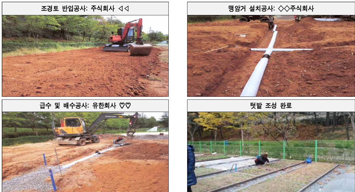
[사진 1] L 텃밭 조성공사 주요 공종별 시공 현황
