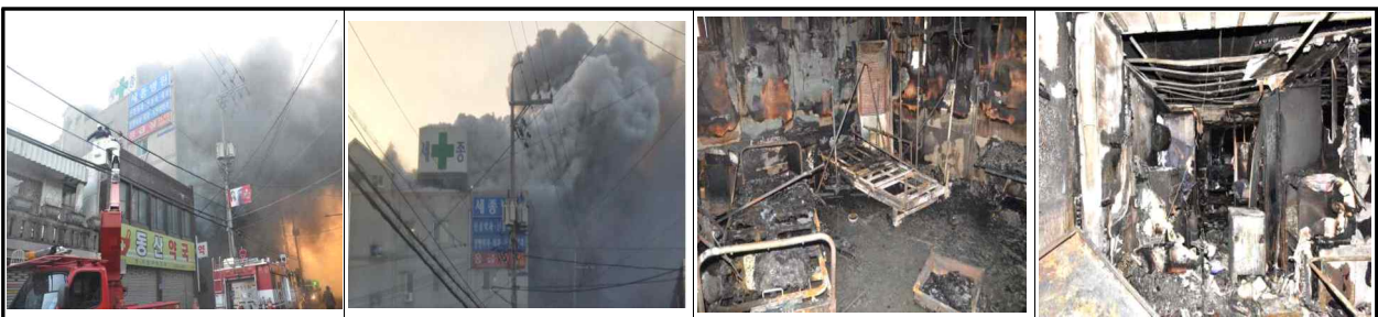
[사진 2] 밀양 세종병원 화재 사고 사진
