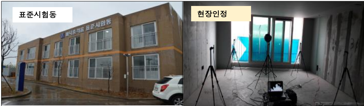
[사진 1] 표준시험동 및 현장인정 사진
