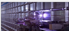
[삼성중공업] 'LNG선 화물창용접용 스파이더 로봇'
