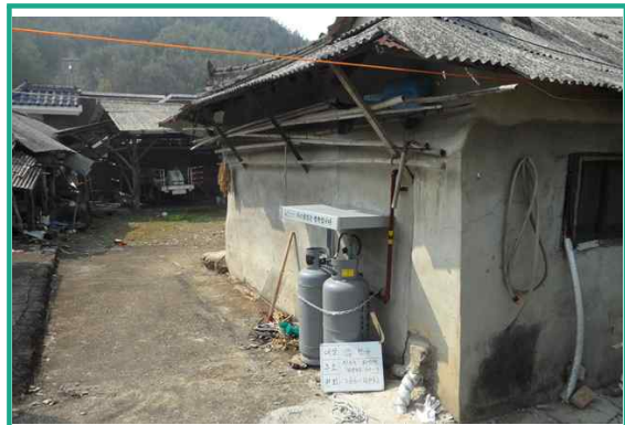
배관시설 교체 및 용기차양설치
