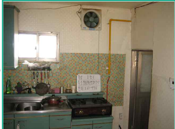
배관시설 교체 및 퓨즈콕 설치
