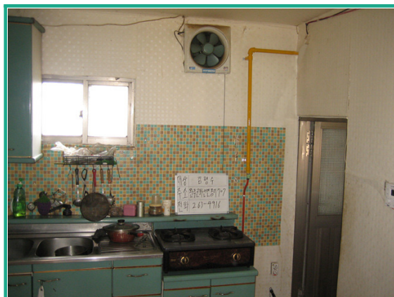
배관시설 교체 및 퓨즈콕 설치
