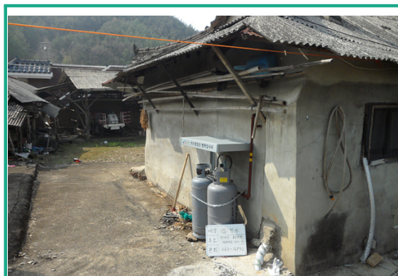
배관시설 교체 및 용기차양설치
