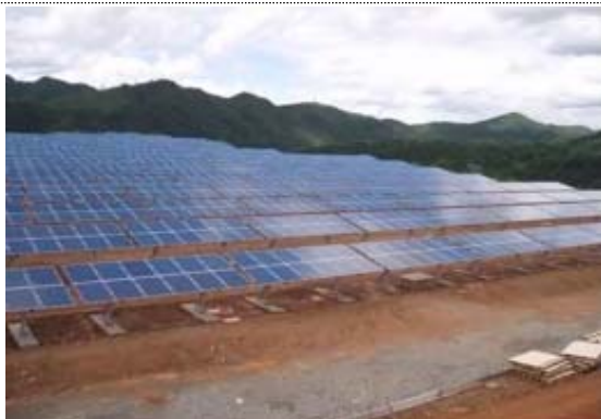
태국 8MW 태양광 발전소 건립
