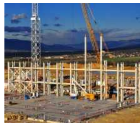
2층 작업 착수('14.12)
