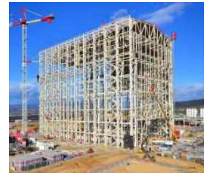
크레인 빔 설치('16.1)
