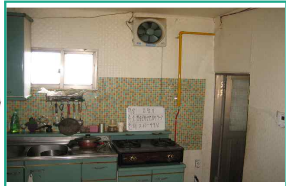
배관시설 교체 및 퓨즈콕 설치
