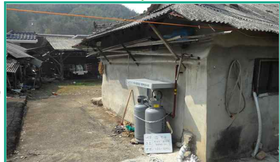
배관시설 교체 및 용기차양설치
