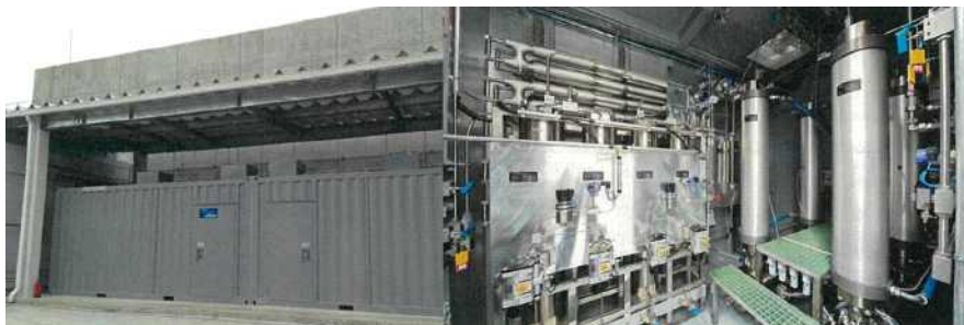
[일본 Hy-TReC 사례 : ionic압축기 : 2,400m 3 /h, 압력 : 110MPa]
