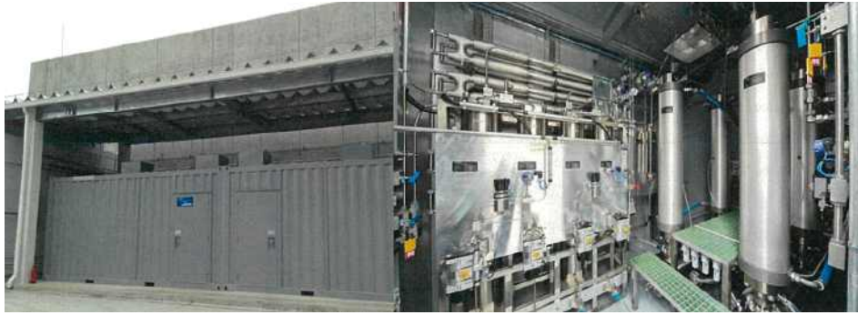
[린데 ionic 압축기 : 2,400m 3 /h, 사용압력 : 110MPa]
