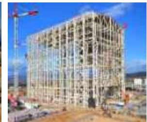
크레인 빔 설치('16.1)
