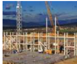
2층 작업 착수('14.12)
