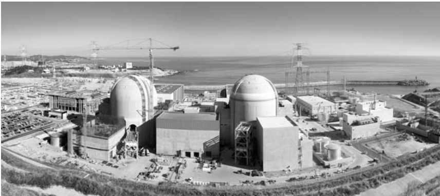
〈그림 2-5〉 신고리 1·2호기 공사현장 전경('10.12)
