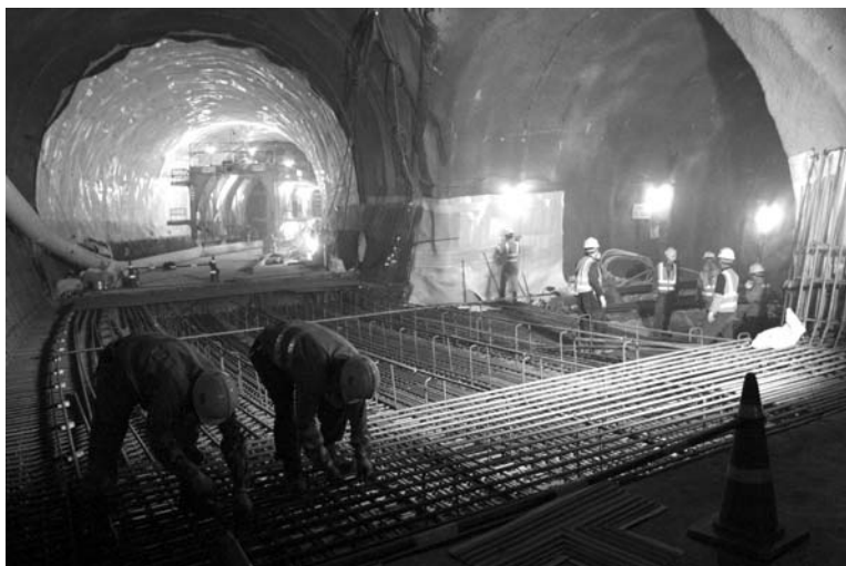
〈그림 3-20〉 횡갱 연결부 기초(인버트) 철근조립
