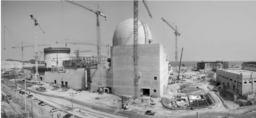
〈그림 2-7〉 신고리 3·4호기 공사현장 전경('10.12)
