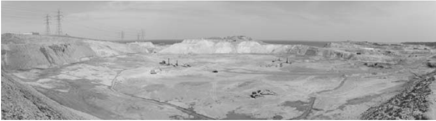
〈그림 2-8〉 신울진 1·2호기 공사현장 전경('10.12)
