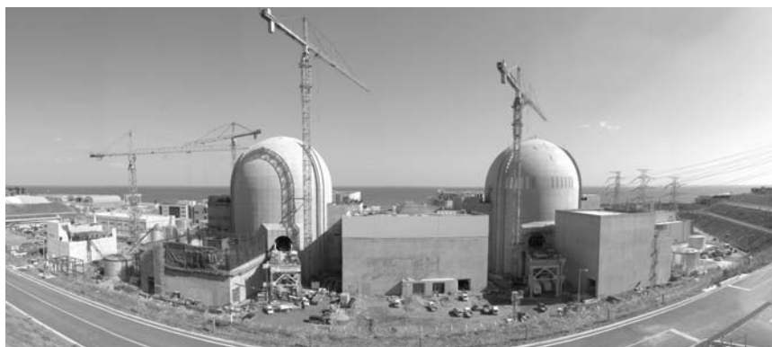
〈그림 2-6〉 신월성 1·2호기 공사현장 전경('10.12)
