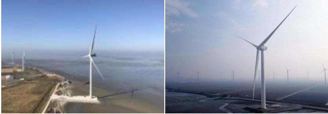
[그림 5-4] 4.3MW급 육상풍력(좌) 및 8MW급 해상풍력(우)
