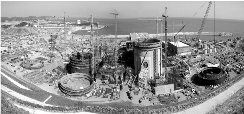
〈그림2-5〉 신고리 1·2호기 공사현장 전경('08. 3)
