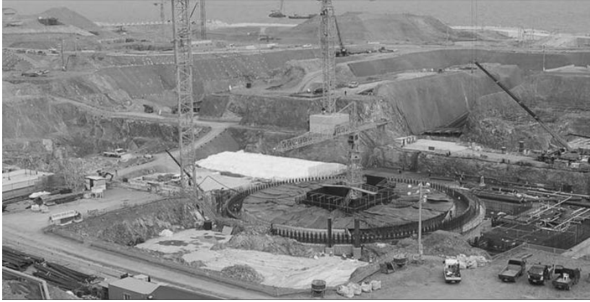
〈그림 2-6〉 신월성 1·2호기 공사현장 전경 ('08. 3)
