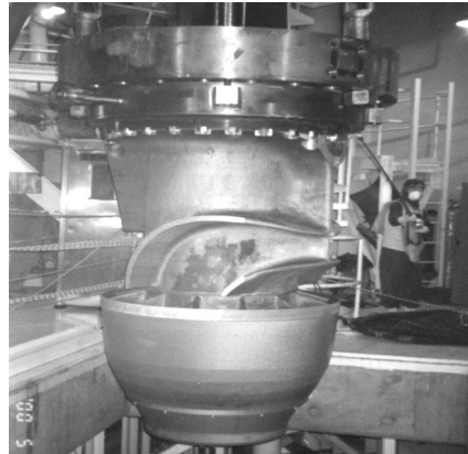
〈그림 2-10〉 고리 1호기 신형 증기발생기 설치, 원자로냉각재펌프 교체
