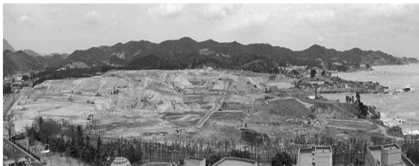
〈그림 2-7〉 신고리 3·4호기 공사현장 전경('08. 3)
