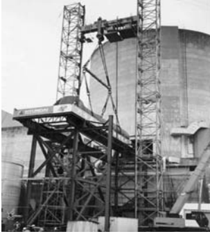
〈그림 2-9〉 고리 1호기 증기발생기 및 원자로냉각재펌프 교체
