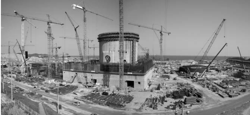
〈그림 2-7〉 신고리 3·4호기 공사현장 전경('09.12)
