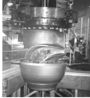
〈그림 2-9〉 고리 1호기 증기발생기 및 원자로냉각재펌프 교체
