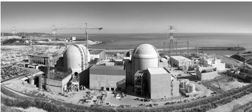
〈그림 2-5〉 신고리 1·2호기 공사현장 전경('09.12)
