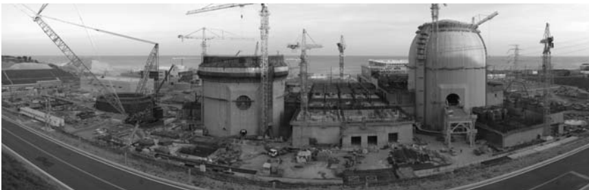
〈그림 2-6〉 신월성 1·2호기 공사현장 전경('09.12)
