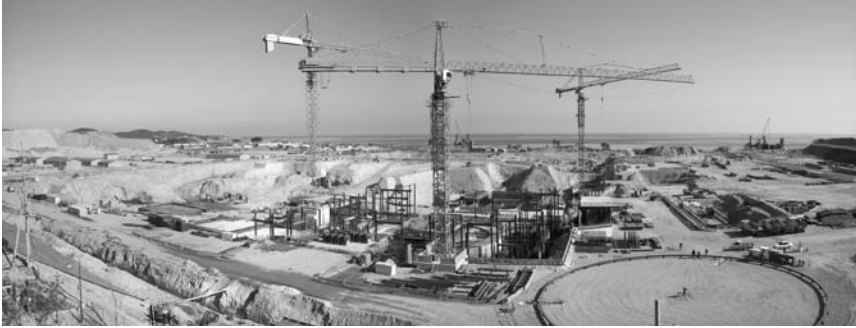
〈그림 2-7〉 신고리 3·4호기 공사현장 전경('08.12)
