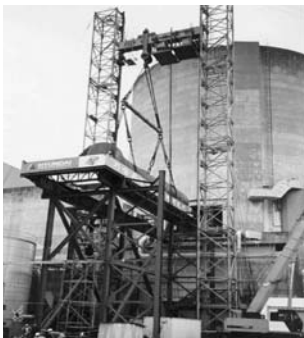
〈그림 2-9〉 고리 1호기 신형 증기발생기 설치, 원자로냉각재펌프 교체
