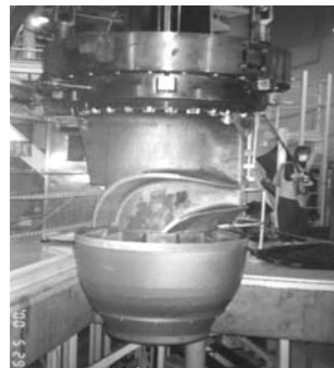
〈그림 2-9〉 고리 1호기 신형 증기발생기 설치, 원자로냉각재펌프 교체
