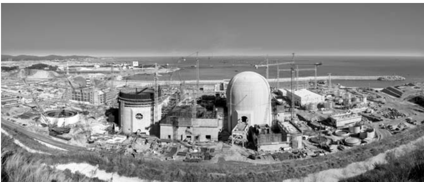
〈그림 2-5〉 신고리 1·2호기 공사현장 전경('08.12)
