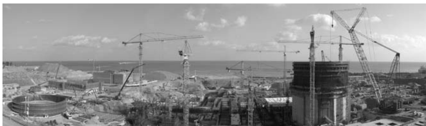
〈그림 2-6〉 신월성 1·2호기 공사현장 전경('08.12)
