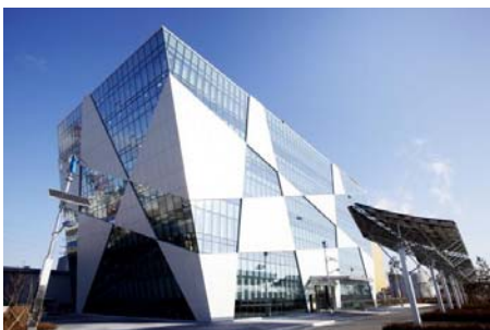
← 신재생에너지 인증 건축물 포스코에너지 인천 신사옥 미래관 (인천 소재)
