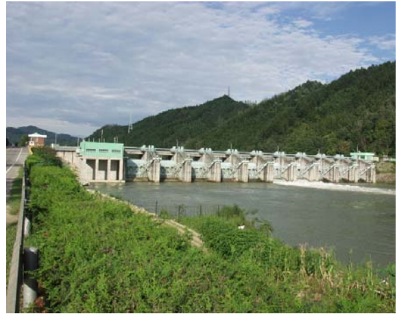
[안동 소수력 발전소(1,500kW)]
