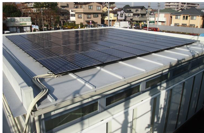
〈로손 편의점 태양광도둑 설치〉
