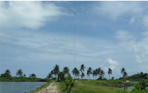
〈 사업예정지에 설치한 풍황측정 기상탑 전경 (높이 100m) 〉
