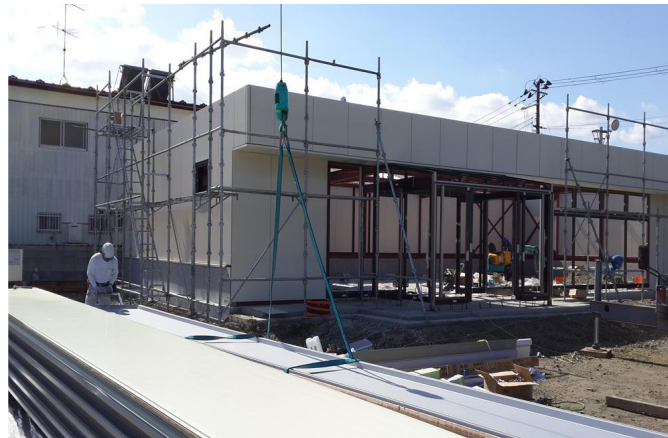
〈로손 편의점 시공 현장〉
