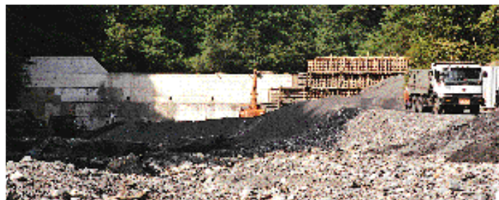
▲ 폐석 유실 방지 공사 - 강원도 영월군 하동면 옥동천 공사
