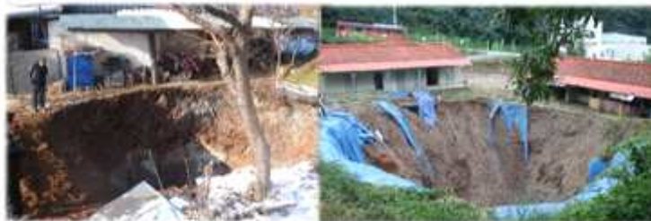
광산 경도 및 채굴적(지하공동) 붕괴로 인한 주거지 지반침하
